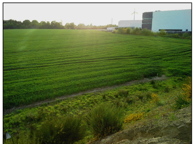
Foto 5: Blick von der im Bau befindlichen Überführung der L 555n über die Welkmannstiege; das westliche Ende des RRB befindet sich am rechten oberen Bildrand, der zuführende Obere Kirchlarchbach wird durch die Gebüschreihe vor den Gebäuden markiert; die Ackerfläche soll überplant werden (Blickrichtung WNW; 10.5.2015)
