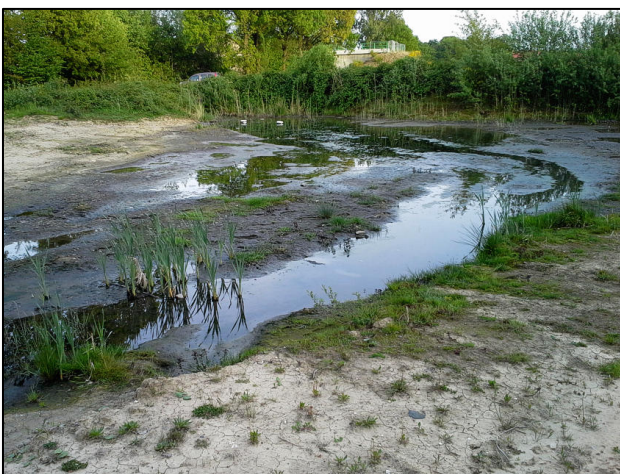
Foto 4: Die östlichste Vertiefung im Mündungsbereich des von Norden kommenden Grabens mit zwei Eimerreusen; im Hintergrund die im Bau befindliche Überführung der L 555n über die Welkmannstiege (Blickrichtung SO; 10.5.2015)
