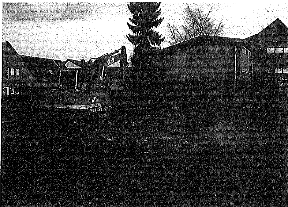
Abbildung 1: Erdarbeiten im Zuge Rückbau Bodenplatte der ehemaligen Werksgaragen, Blick zur Felix Fraling-Straße/alte Übergabestation RWE (Ortstermin 12.01.2005)
