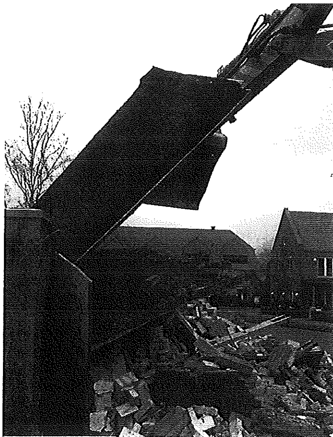
Abbildung 10: Rückbau alte Übergabestation RWE, Separierung Dach, Blick Richtung Felix-Fraling Straße (Ortstermin 09.03.2005)
