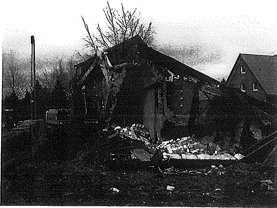
Abbildung 9: Rückbau alte Übergabestation RWE, Blick Richtung Felix-Fraling Straße (Ortstermin 09.03.2005)
