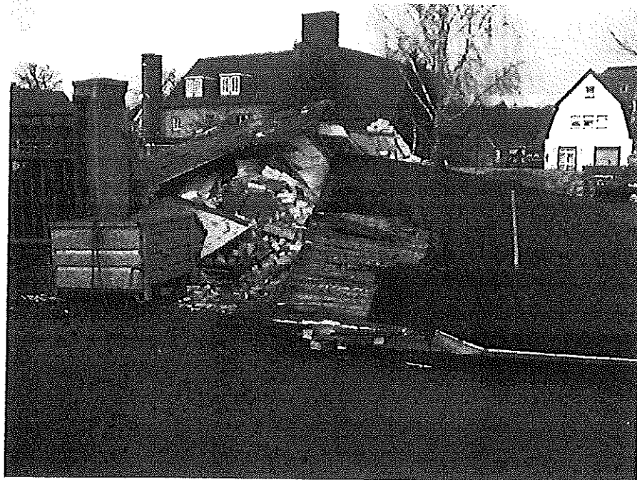
Abbildung 11: Rückbau alte Übergabestation RWE, Separierung Dach, (Ortstermin 09.03.2005)
