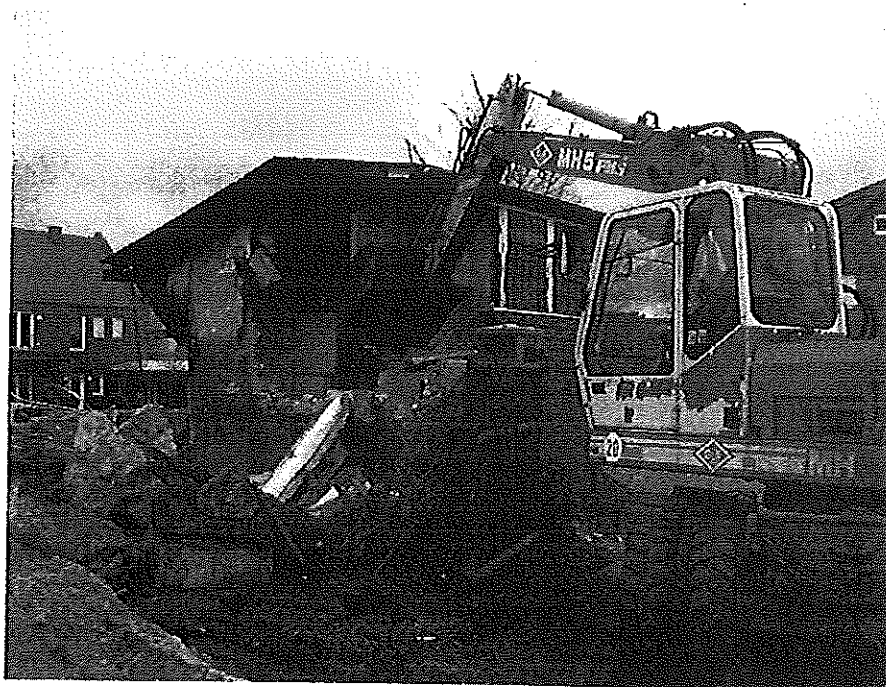
Abbildung 8: Rückbau alte Übergabestation RWE, Blick Richtung Felix-Fraling Straße (Ortstermin 09.03.2005)
