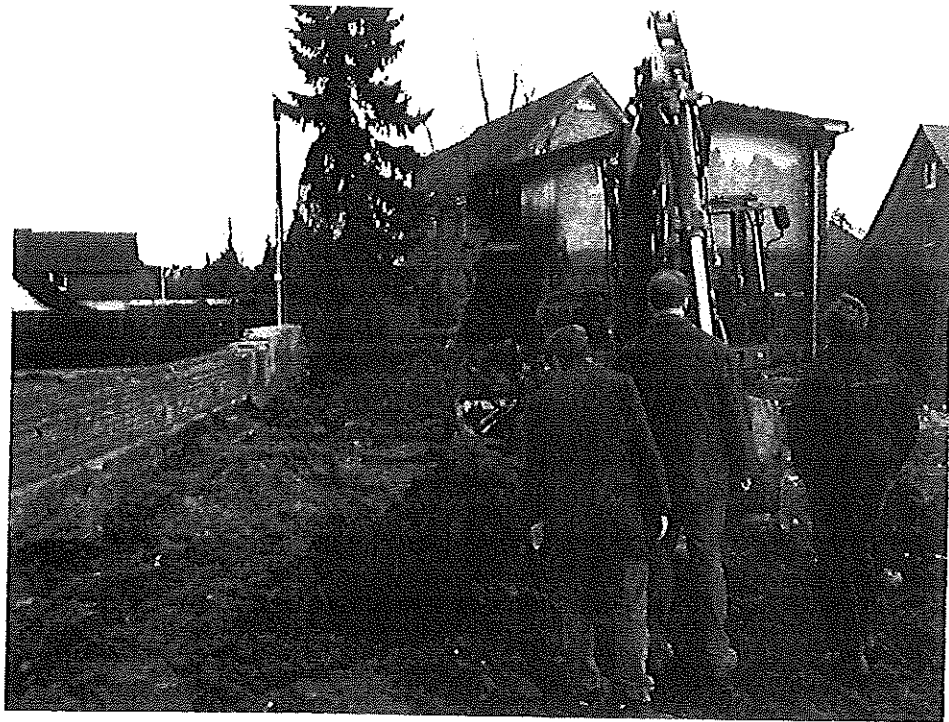
Abbildung 3: Durchführung Baggerschurf im Zuge Rückbau Bodenplatte der ehemaligen Werksgaragen, Blick zur Felix Fraling-Straße/alte Übergabestation RWE (Ortstermin 12.01.2005)
