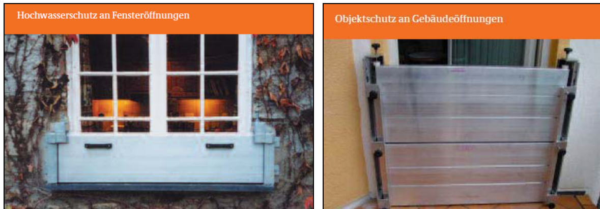
Abbildung 29: Beispiele für Bauvorsorge (Quelle: Bundesbauministerium)
